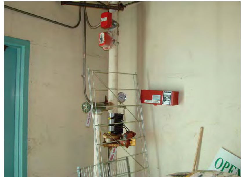
029 P_E: Fire sprinkler riser.
